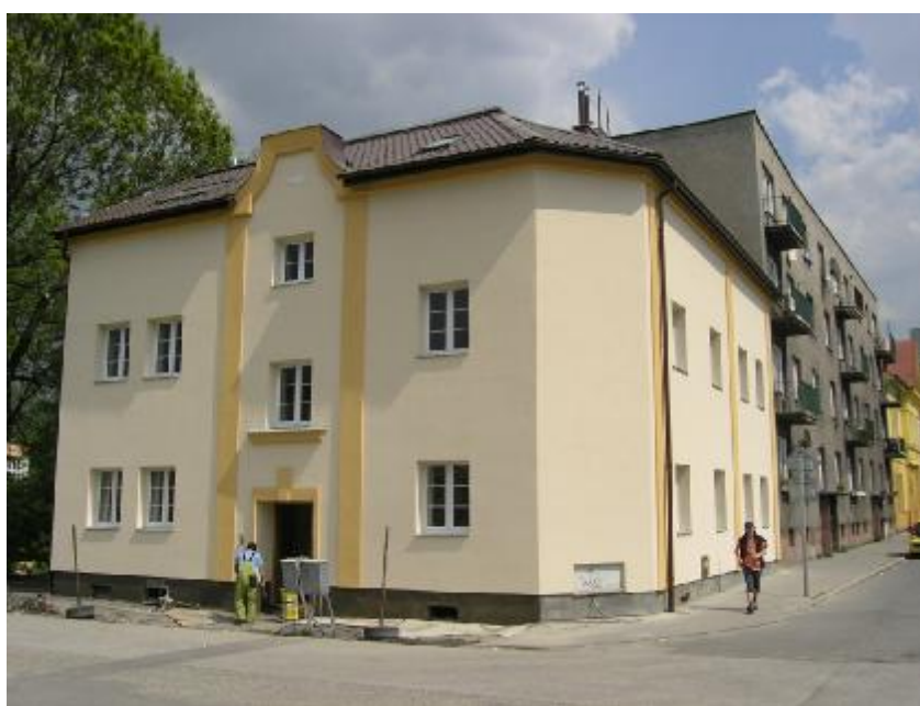
Obr. 2. Tentýž dům těsně před dokončením rekonstrukce
