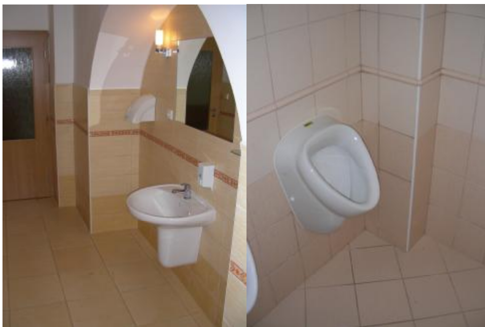
Obr. 1. Rekonstruované sociální místnosti
