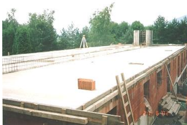
Další etapa hrubé stavby: nosné stěny, stropy , výtahová šachta.
