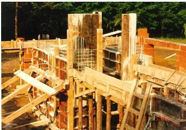
Další etapa hrubé stavby: nosné stěny, stropy , výtahová šachta.
