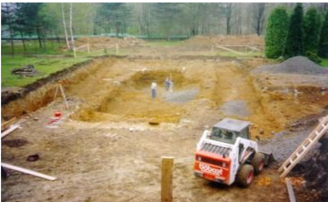
Výkopy a betonáž základových pasů.
