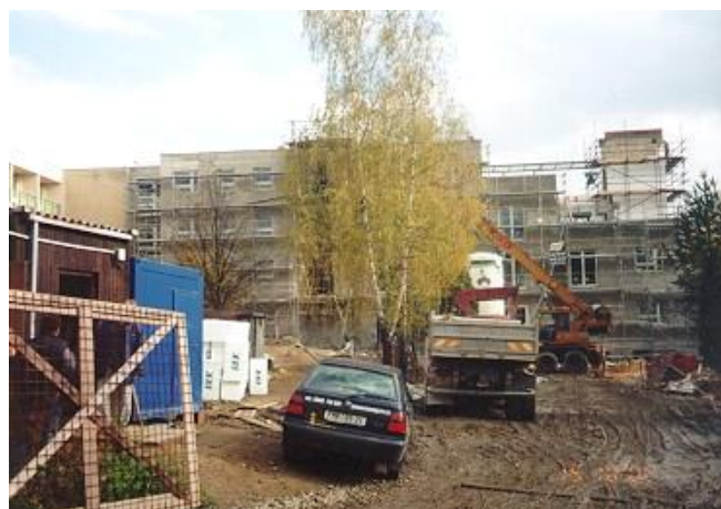
Práce na venkovních povrchových úpravách – zateplení a vnější omítky.
