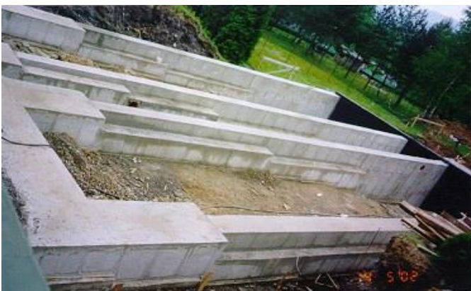
Výkopy a betonáž základových pasů.
