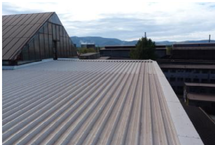
Obr. 1. Rekonstruovaná střecha po výměně původní střešní konstrukce za trapézové plechy
