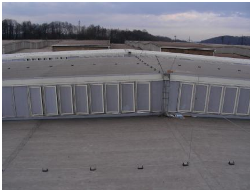
Obr. 1. Rekonstruovaná střecha po výměně původní střešní konstrukce za panely Kingspan
