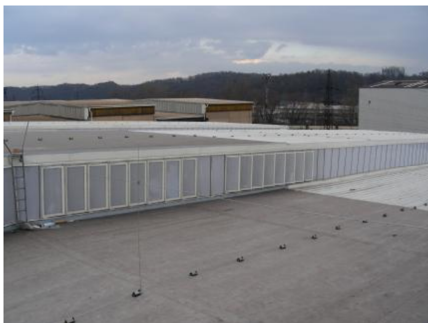
Obr. 2. Prosvětlovací pásy světlíků po repasi, montáž nového hromosvodového systému
