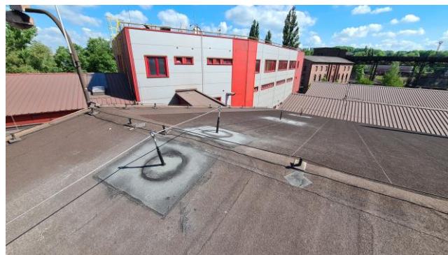
Obr.2 – Objekt 5 - Dokončovací hala
