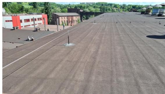
Obr.4 – Objekt 6 – Pecní hala
